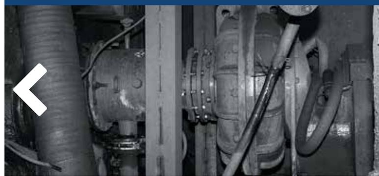
SE UTILIZA PARA TRANSPORTAR LA PULPA DESDE LA ZONA DE SUCCIÓN DE LAS BOMBAS EN LAS SECCIONES DE INYECCIÓN, AFINACIÓN Y FLOTACIÓN.
